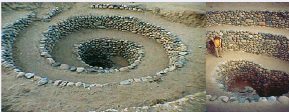
Рис. 5.11: Система сбора воды в Наска (южное побережье Перу) для подземных акведуков и подачи в слою грунтовых вод
